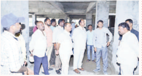
నిర్మాణ పనులను పరిశీలిస్తున్న గద్వాల ఎమ్మెల్యే బండ్ర కృష్ణమోహన్‌రెడ్డి
